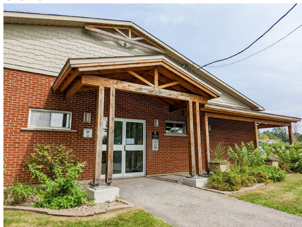
Figure 7 — Salle communautaire Édifice Gilles-Grenier
