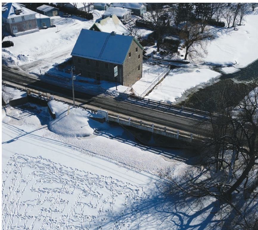
Travaux d'affaiblissement préventifs sur la rivière Delisle réalisés par la MRC de Vaudreuil-Soulanges en mars 2025.
